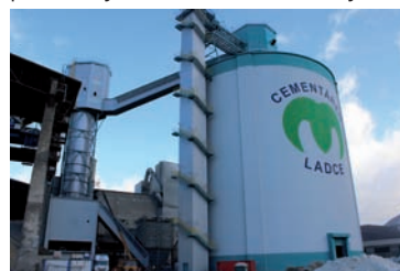
Obr. 8 Nové slinkové silo
