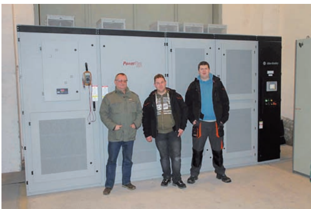
Obr. 6 Konateľ ELMARK PLUS Ing. Ivan Vik (vľavo) a dvaja technici spoločnosti pri funkčných skúškach PowerFlex 6000
