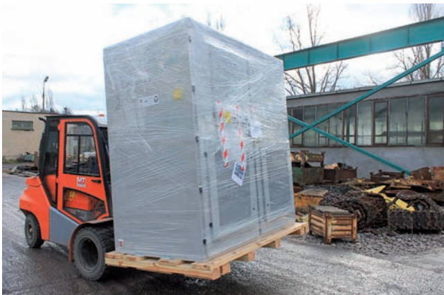
Obr. 5 Prevoz častí frekvenčného meniča na miesto montáže v areáli ventilátorovne Jamy „F“
